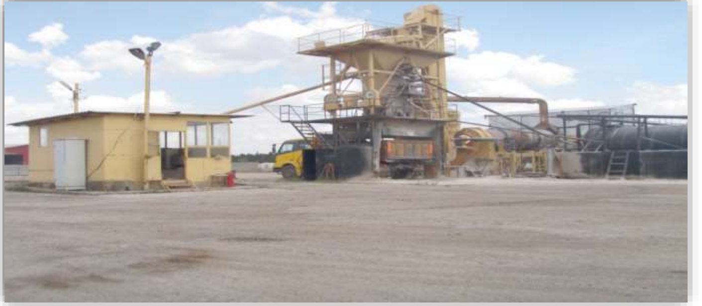
HAVSA ASFALT ŞANTİYESİ
